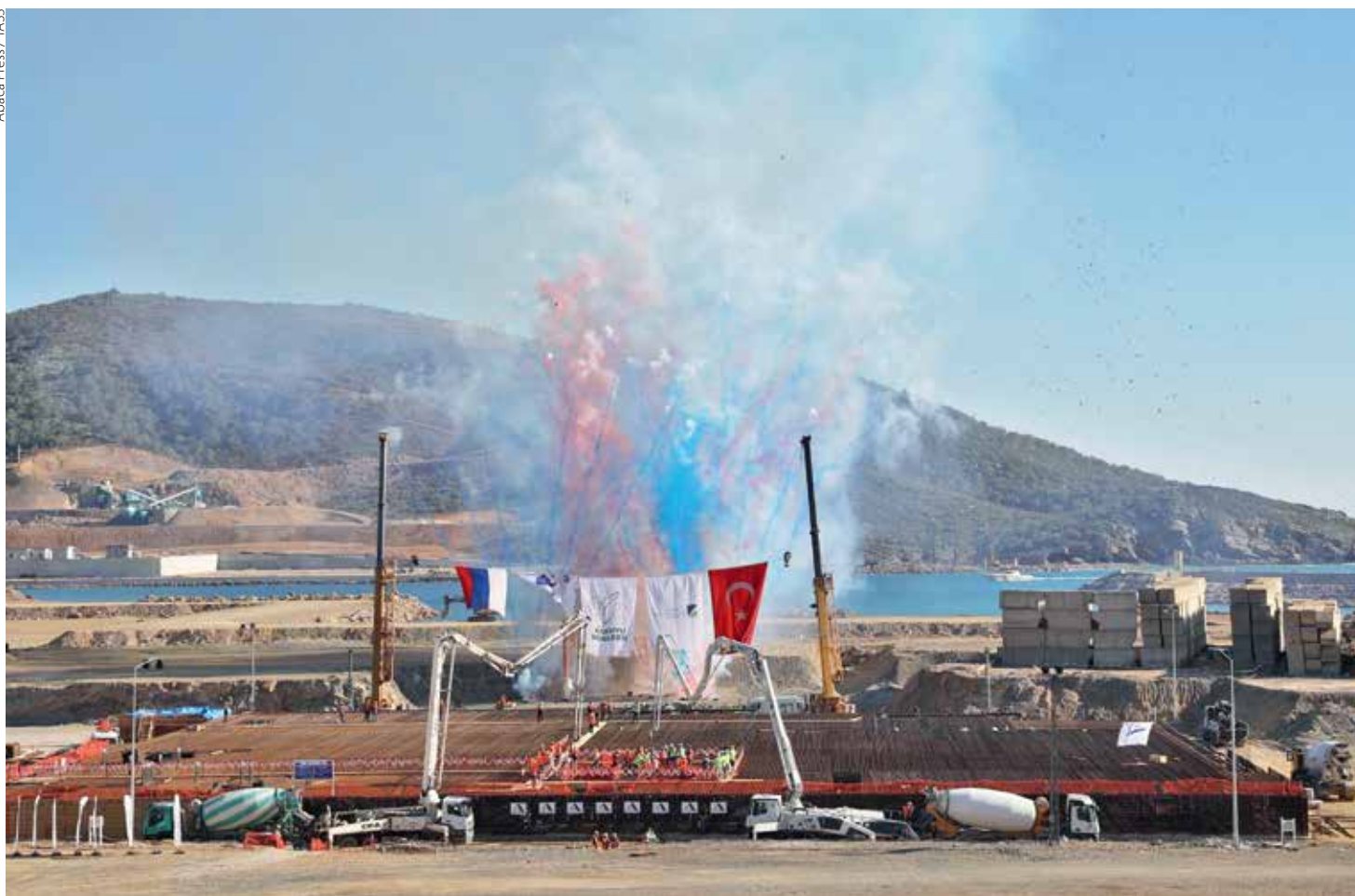
Церемония закладки фундамента первой турецкой АЭС «Аккую»
