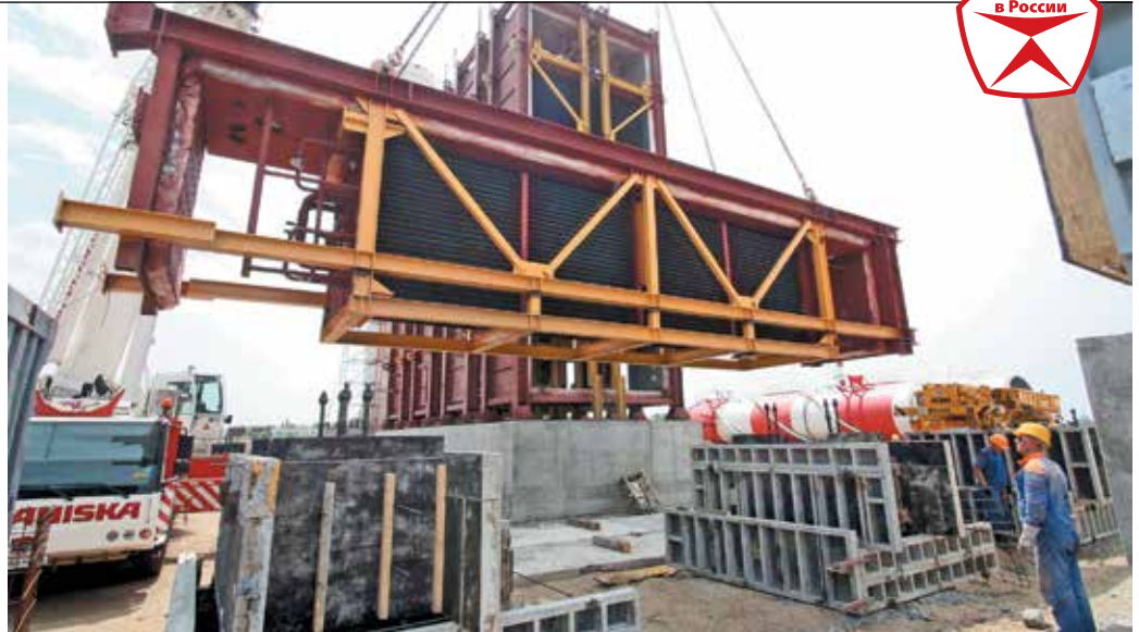
Монтаж котла-утилизатора за газовой турбиной (КГТ)
