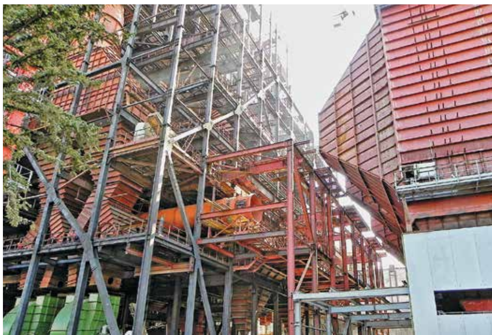
Монтаж котла с ЦКС на блоке № 9 Новочеркасской ГРЭС
