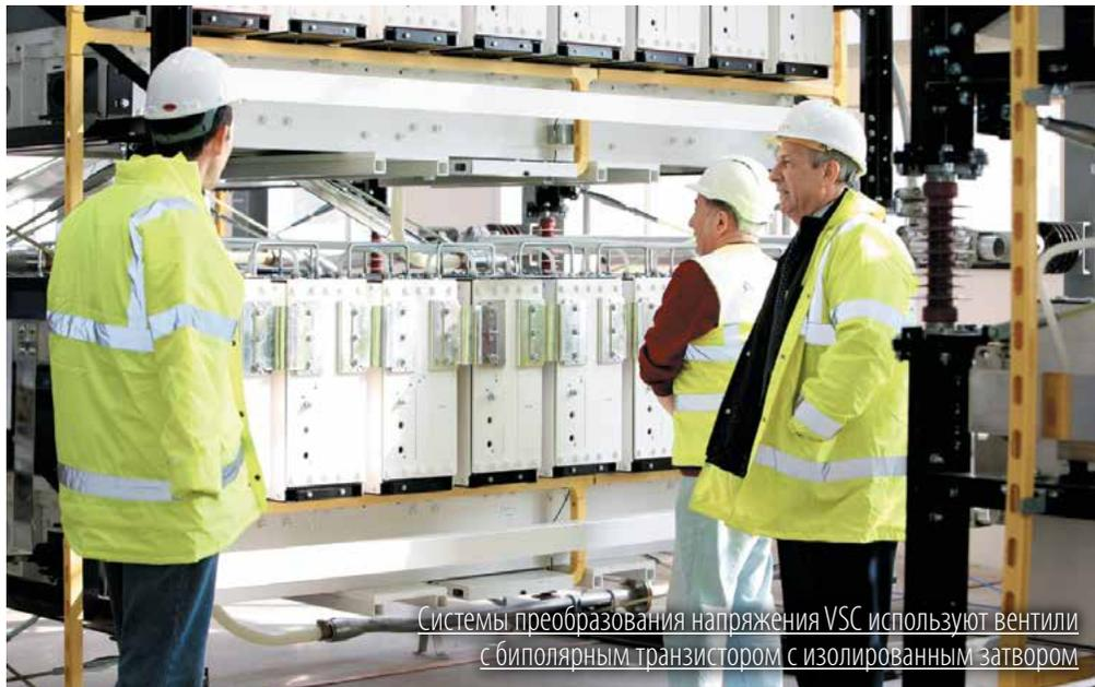
Системы преобразования напряжения VSC используют вентили с биполярным транзистором с изолированным затвором
