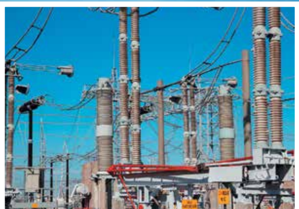
Так выглядит конденсатор связи на линии электропередачи, разрушение которого стало причиной блэкаута
